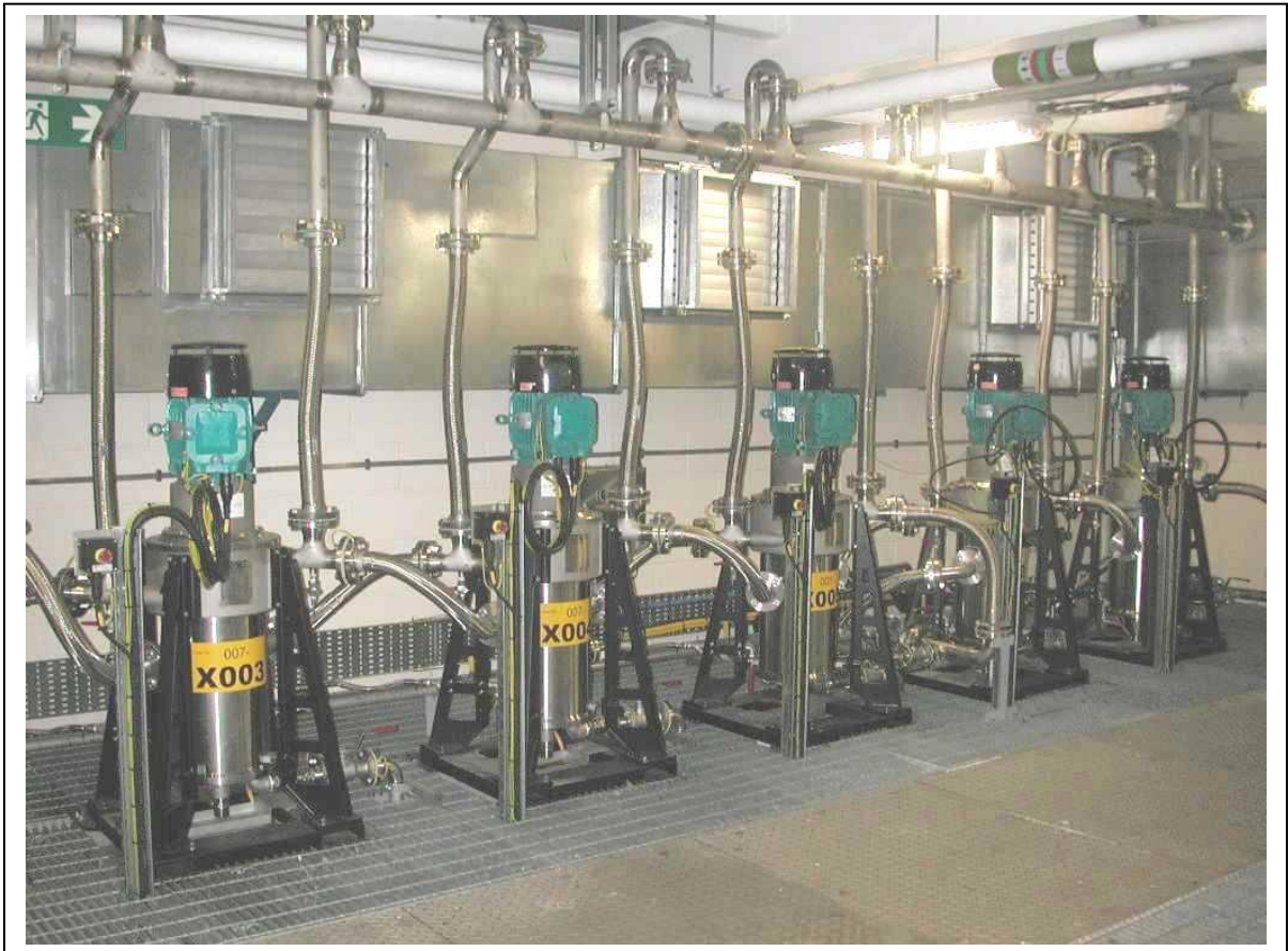
Abb. 3 Prozeß: 5 stufige Gegenstromextraktion Model V10
